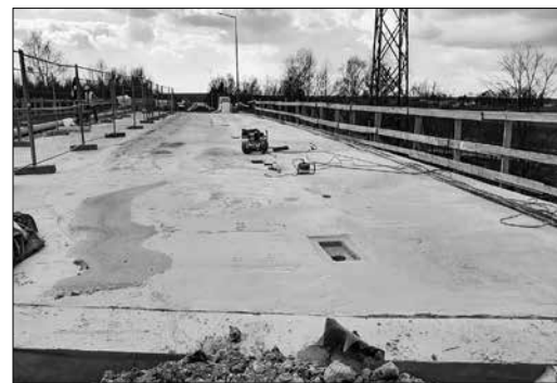
Przebudowa mostu w Suszcu
