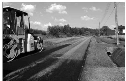
Nowa nawierzchnia w Kobielicach
