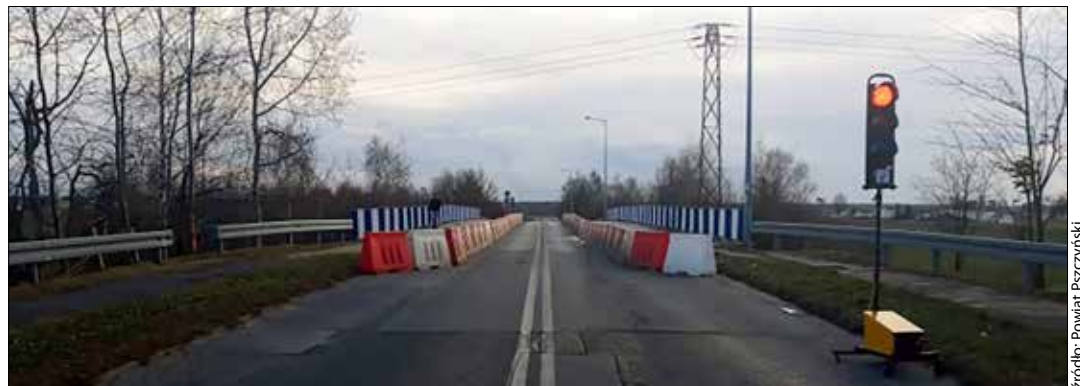
Przygotowania do remontu wiaduktu
